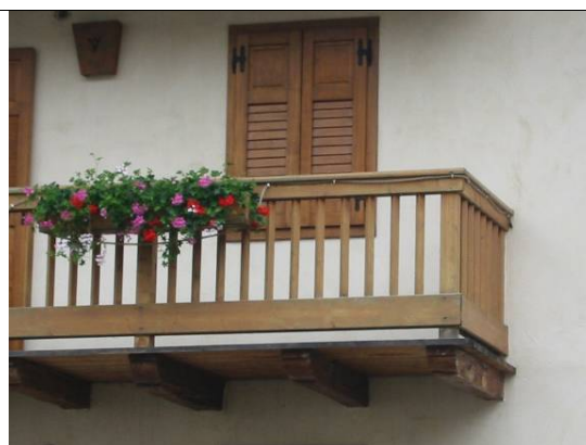
Balcone con parapetto in legno a ritti verticali e struttura e impalcato in un recente intervento
