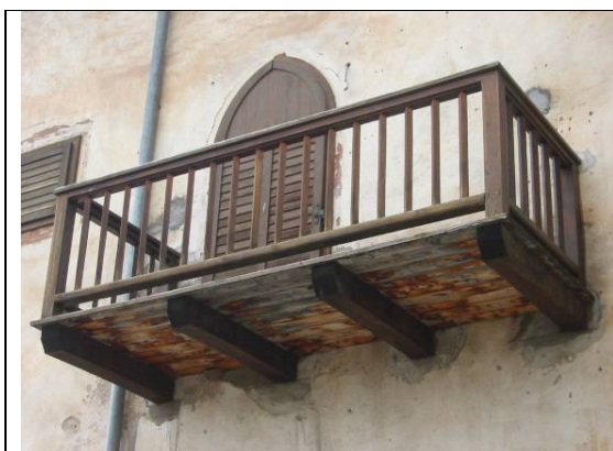
Antico balcone con parapetto in legno a ritti verticali e struttura e impalcato in legno
